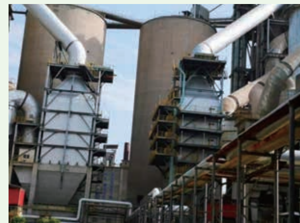
池州海螺SCR脫硝技改現場
